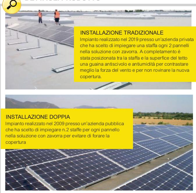
La zavorra è un massello in calcestruzzo ideale per installare in modo efficace e sicuro i pannelli su superfici o tetti piani. Soluzione economica e di rapida installazione ma al tempo stesso estremamente sicura, per tutte quelle situazioni in cui i pannelli non possono essere posizionati inclinati e non è possibile forare la superficie. L'installazione si completa con le nostre staffe a L in alluminio e vite M10x250mm.
